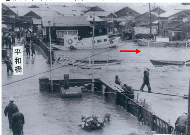
③浸水被害状況(昭和43年8月21日)
