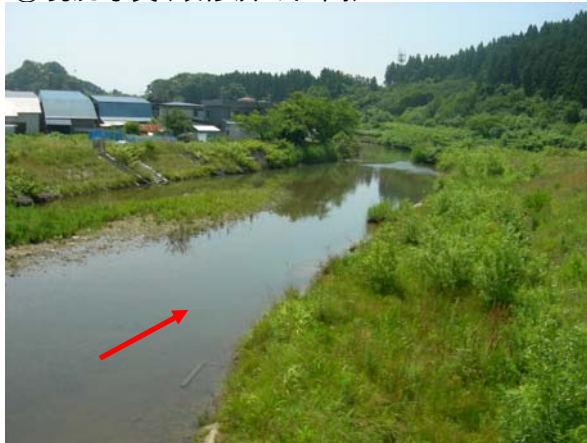
②現況写真(改修済み区間)
