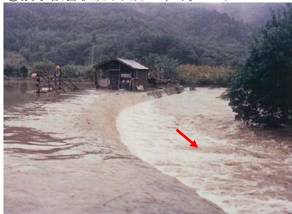
④浸水被害状況(平成12年7月25日)
