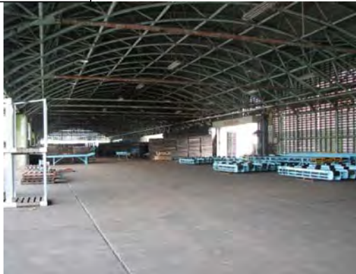
館鼻地区：荷捌所B棟
