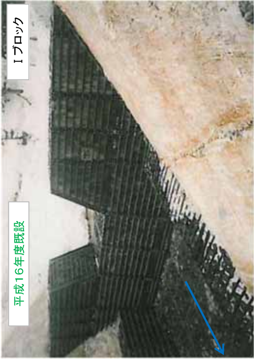
⑮ 鋼製自在枠床固工
