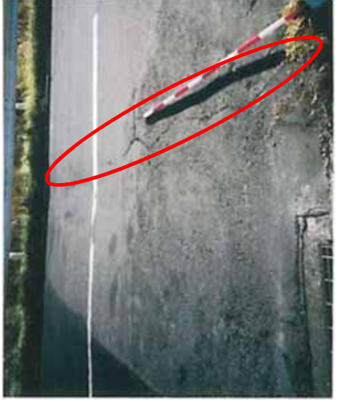
⑤ 国道454号の舗装路面亀裂状況(Vブロック)
