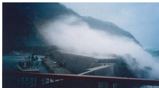
外郭施設の整備不足により、越波及び開口部からの波の進入があり、港内静穏度が非常に悪く、漁船の係留等に支障がある。
