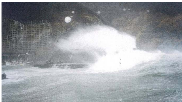
外郭施設の整備不足により、越波及び開口部からの波の進入があり、港内静穏度が非常に悪く、漁船の係留等に支障がある。
