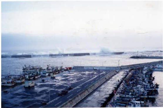
波浪による防波堤越波状況
