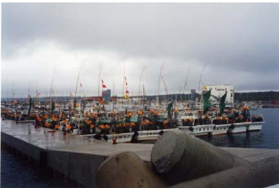
安全に係船ができる岸壁が不足しているため、外郭施設(突堤)にも係船している。
