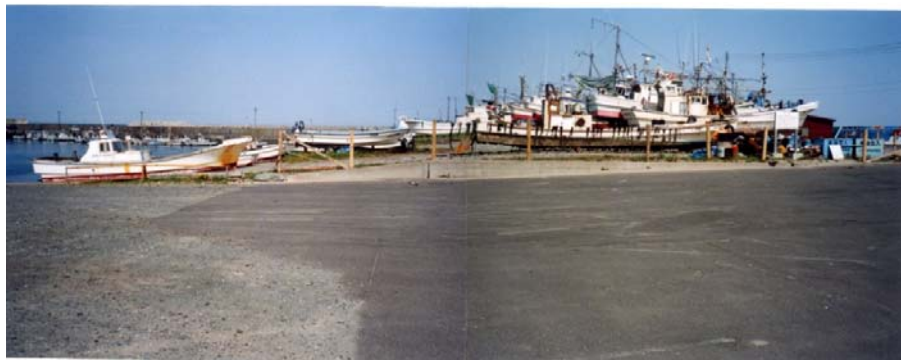
船揚場用地が狭隘なため漁船の維持管理、簡易修繕に支障をきたしている。
