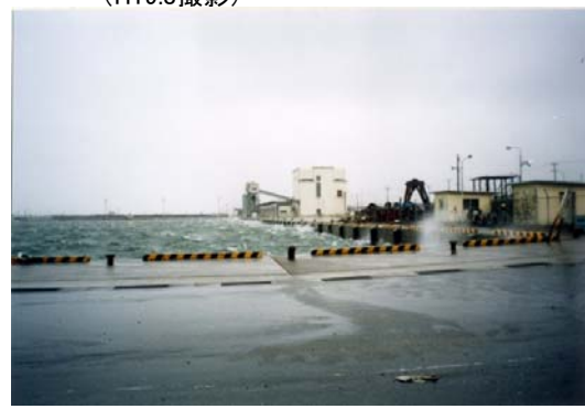
低気圧の通過により港内が荒れている状況 漁船が安全に係船出来ないため避難している
