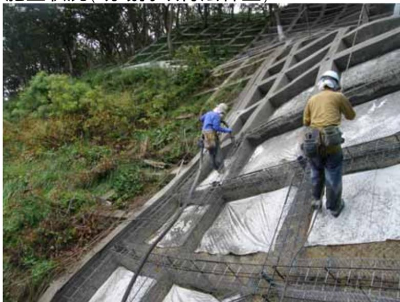
施工状況(鉄筋挿入工)
