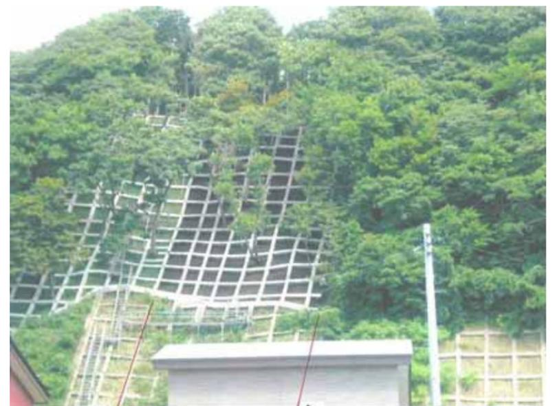
施工状況(現場打吹付法砕工)
