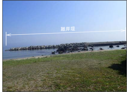
離岸堤 全景写真
