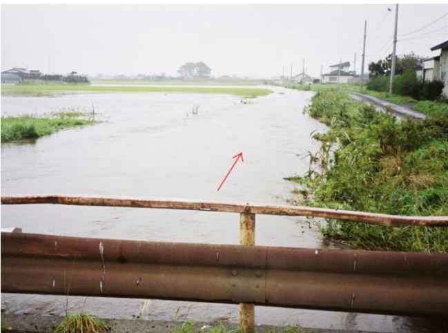
浸水被害状況(平成13年9月)
