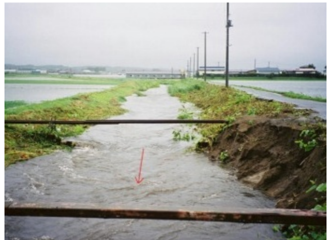
浸水被害状況(平成14年7月)
