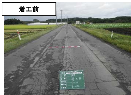
路面等の状況写真
