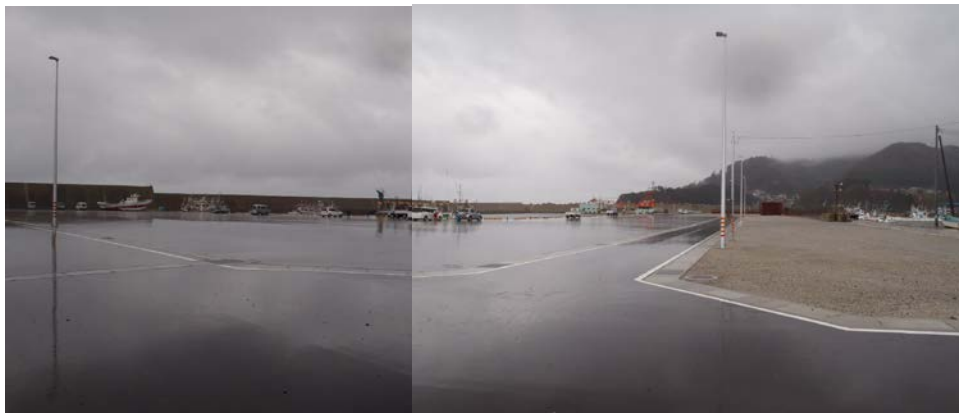
舗装工：道路、用地整備状況
