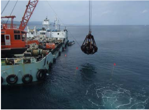
基礎工：基礎捨石投入状況
