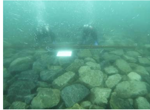
基礎工：基礎捨石均し状況
