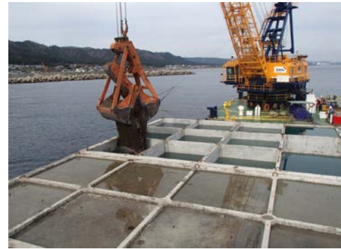
本体工：ケーソン据付状況
