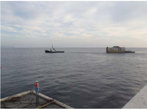
本体工：ケーソンえい航状況
