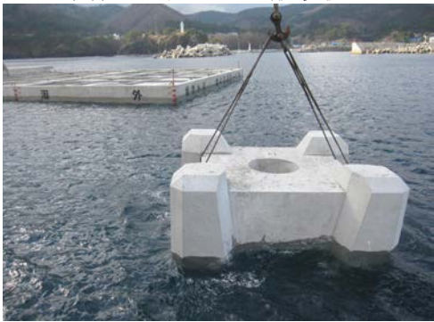
被覆工：被覆ブロック据付状況
