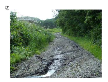
・未舗装かつ急勾配、排水施設が未整備のため、台風 等大雨災害時、路盤が流出 され通行が不可となる。
