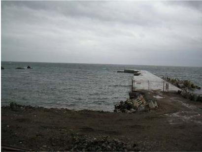
海岸から細長く突出して設けられるものであり、砂の動きを制御することによって、海岸線の維持あるいは前進を図ることを目的とした施設。
