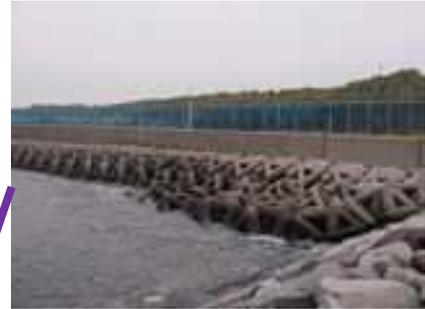
波の勢いを弱めて、越波を減少させたり、堤防・護岸を保護したりする目的で設置されたコンクリートブロックで構成される構造物。
