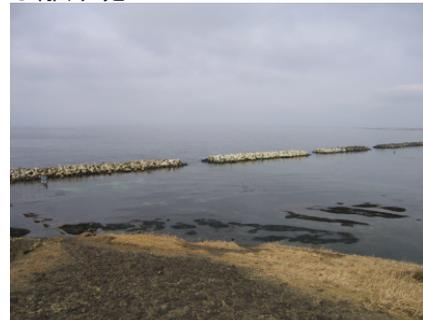
波の勢いを弱め、越波を減少させたり、背後に砂を貯えて、砂浜の侵食を防ぐ施設。
