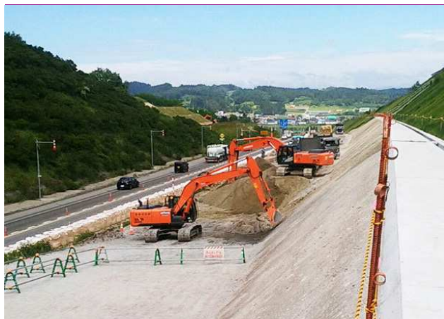
工事現場の風景
