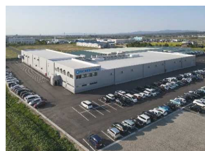
津軽工場 全景
