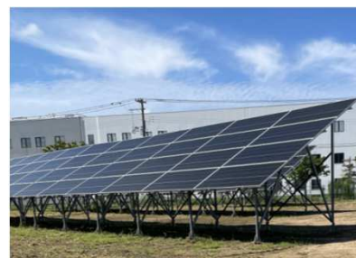
積雪対策した太陽電池架台
