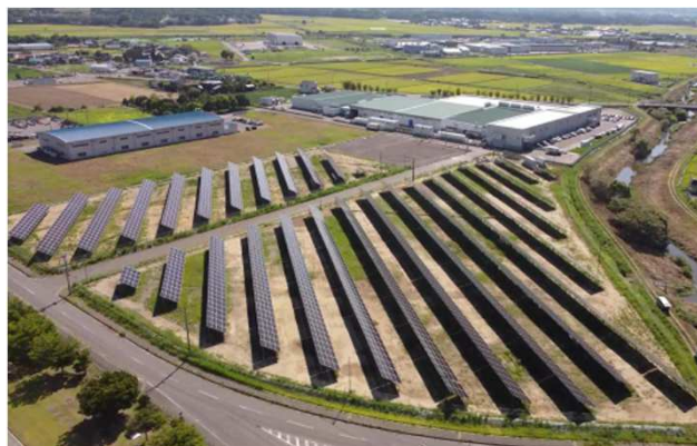
太陽光発電設備（手前）と津軽工場（奥側）
