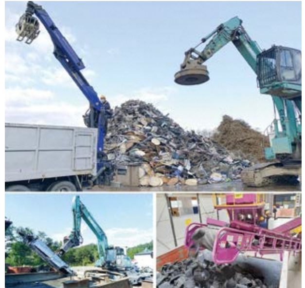
金属、廃車、廃タイヤの処理設備
