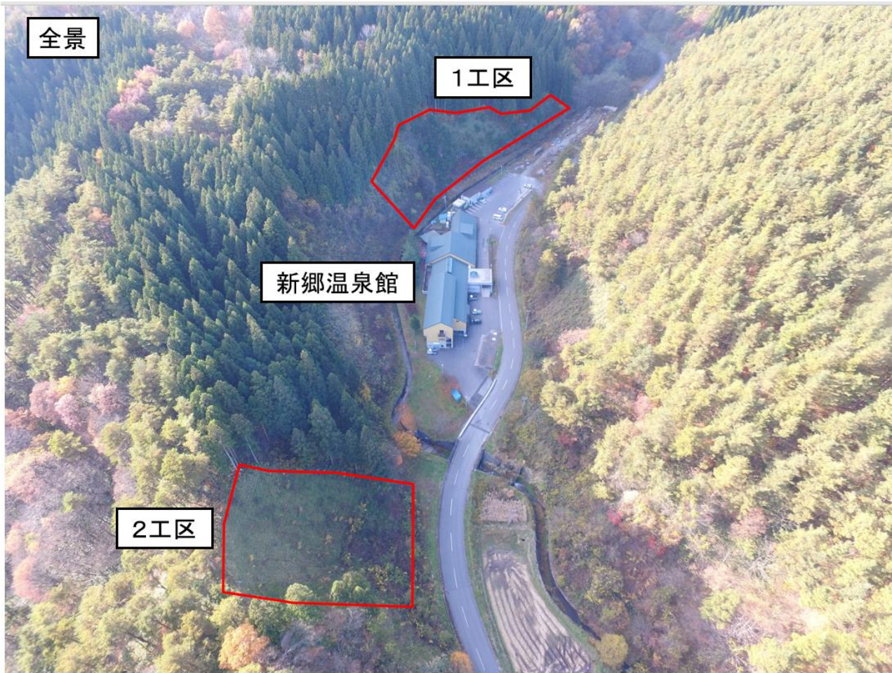
【現在の状況 全景写真①】
