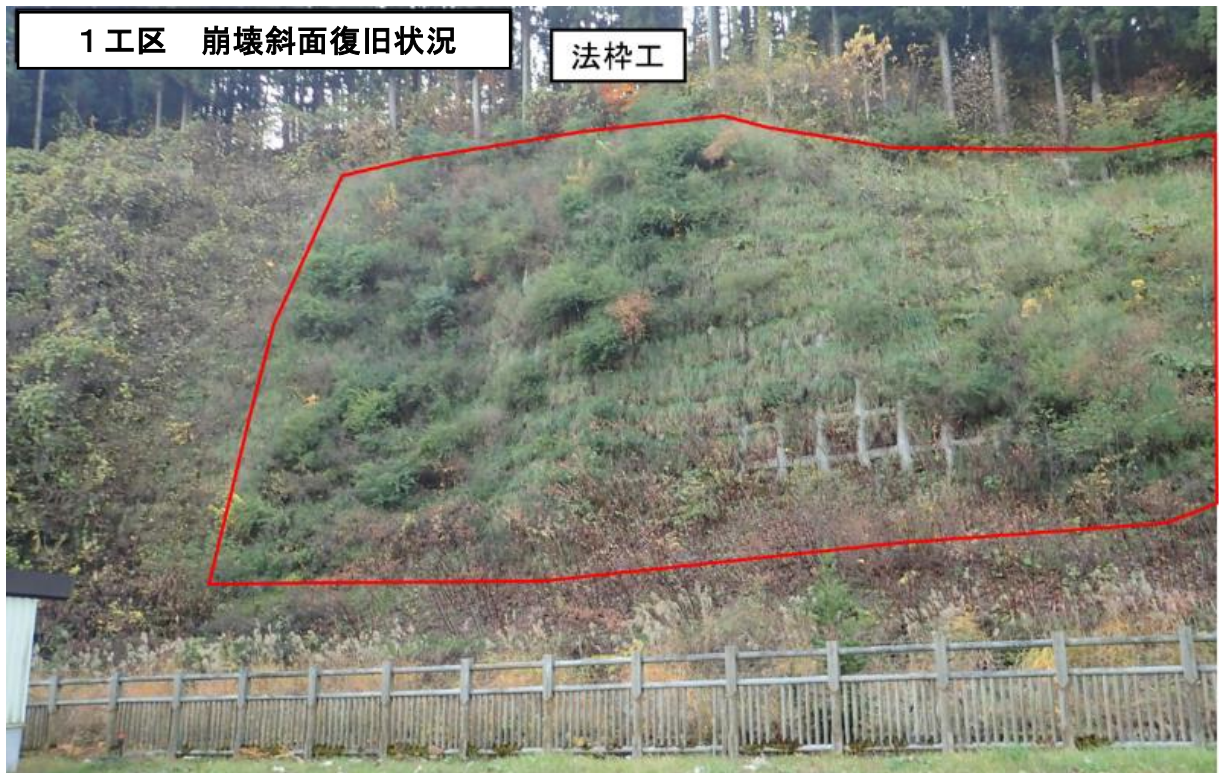
【現在の状況 写真②】
