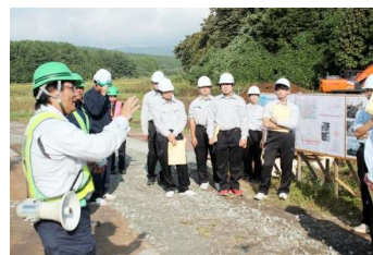
下北半島縦貫道路建設現場(横浜町)
