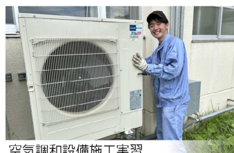
空調和設備施工実習
