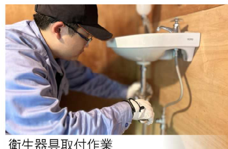
衛生器具取付作業
