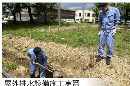
屋外排水設備施工実習
