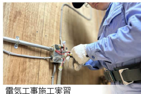
電気工事施工実習
