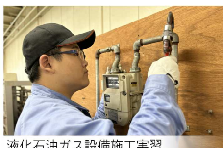
液化石油ガス設備施工実習
