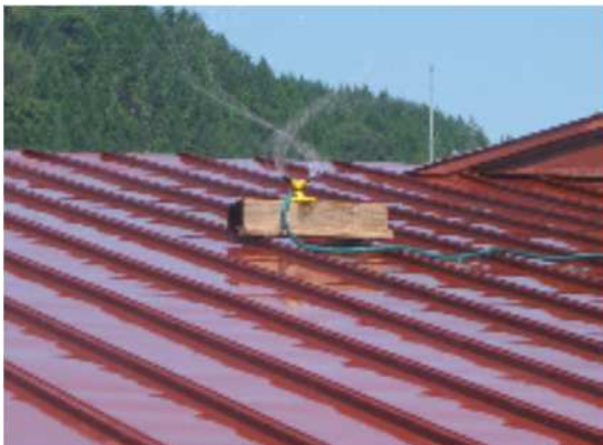
屋根への散水
