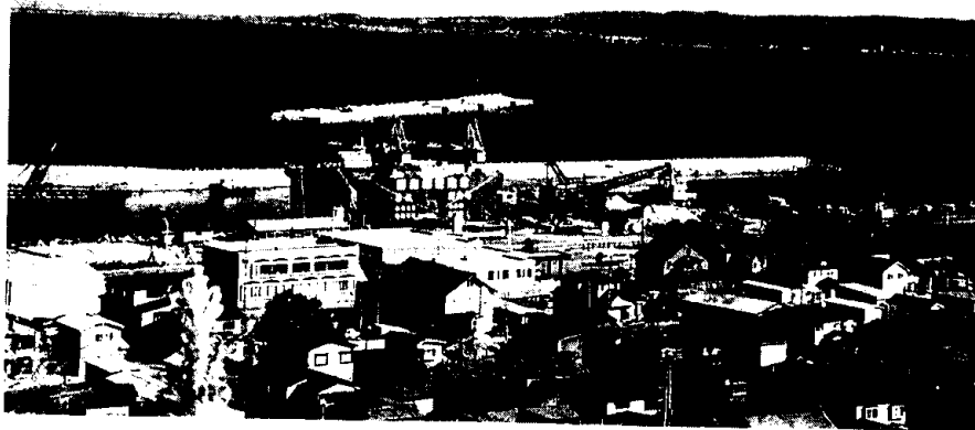
写真1 北金ヶ沢漁港と多機能静穏域
