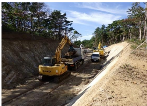
集落道施工状況（大間町）
