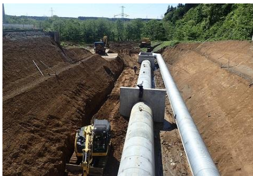
底樋施工状況
