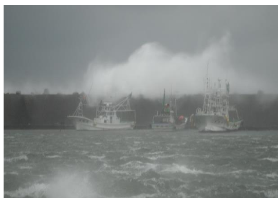
防波堤からの越波により、港内の静穏度が悪化している
