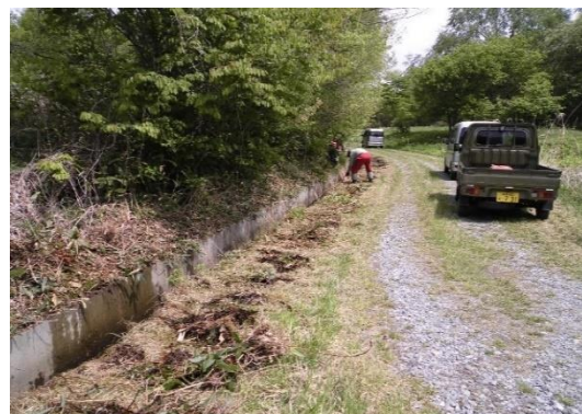
水路の泥上げ（東通村）
