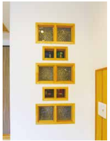
明かり取りとして玄関ホールの壁面にはめ込まれたブロックガラス
