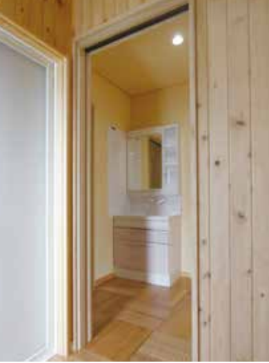
脱衣室の壁には青森ヒバ (左手がユニットバス、奥が洗面所)
