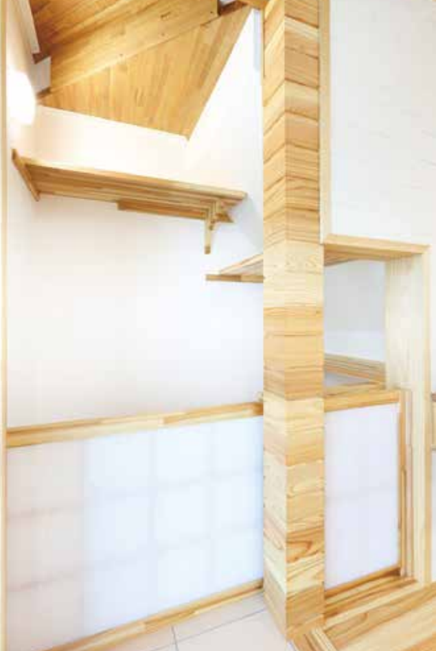
造作に4日かかったという羽目板を張り合わせた柱
