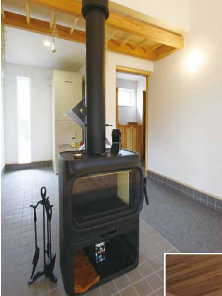
家全体の暖房をまかなう玄関土間に設置した薪ストーブ
