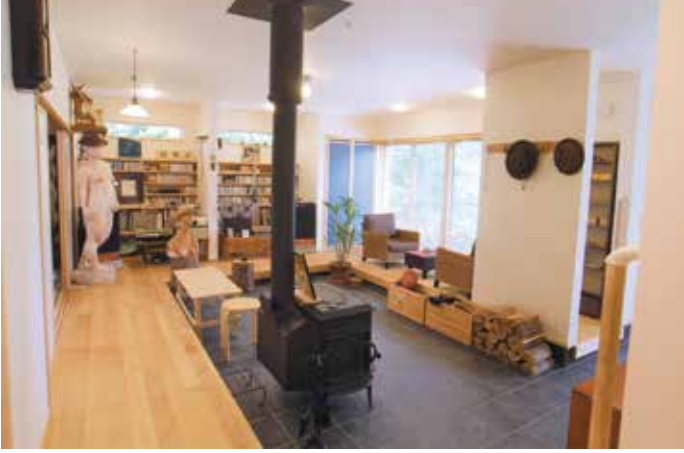
以前の和室は薪ストーブを楽しむ土間にリフォーム
