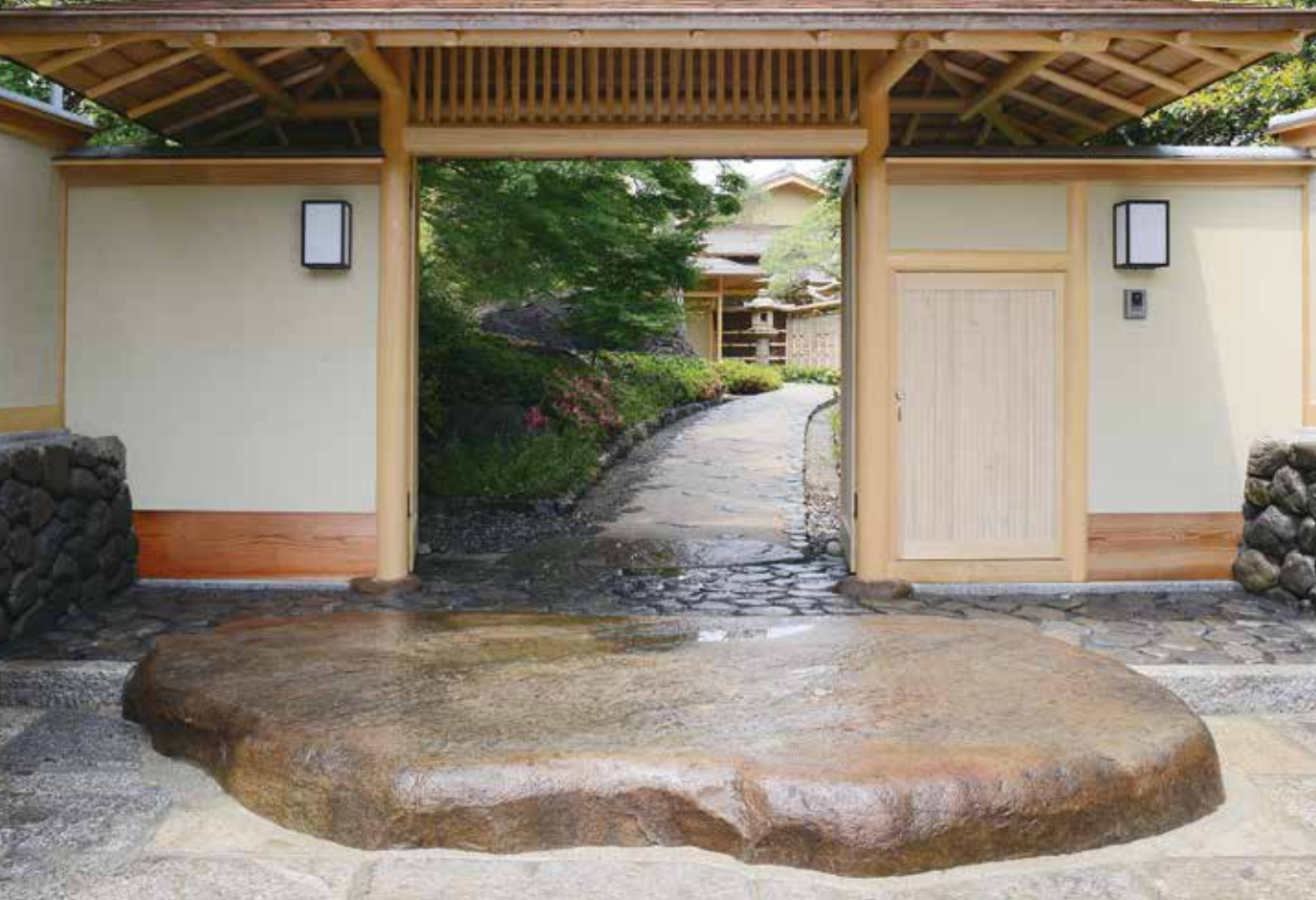
大工の技術の高さが光る寄棟造りの門
