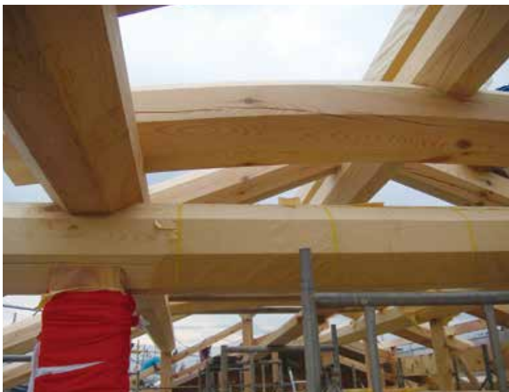
リビングの天井に現わしになっている八角形のアカマツの丸太梁(五戸町、S様邸)
