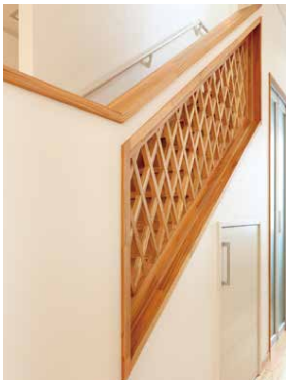
職人の技が光る階段の斜面に沿って斜めに組み込まれたひし形のラティス
