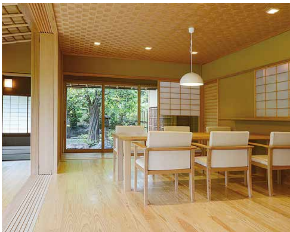
ダイニングの天井は杉根を網代市松張りに。網代の幅を広くすることで堂々とした風情となった
