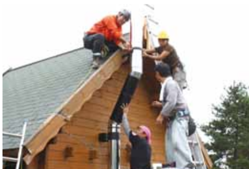
ログハウスに煙突を取り付ける相馬代表たち
