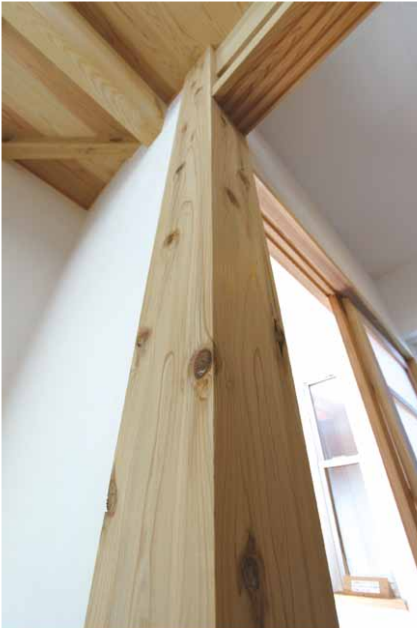
施主自ら伐り出したスギを使用した6寸角の大黒柱
