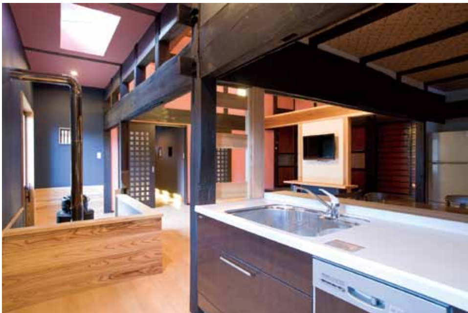
古い梁や鴨居を生かしつつ、新築同様に生まれ変わった居間と台所
