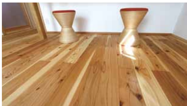
床のスギ板には自然塗料が塗られている
