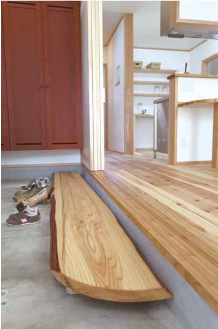
玄関の式台にも施主が伐り出したスギが使用されている
