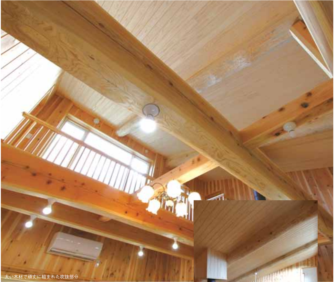
太い木材で頑丈に組み立てられた吹抜部分
