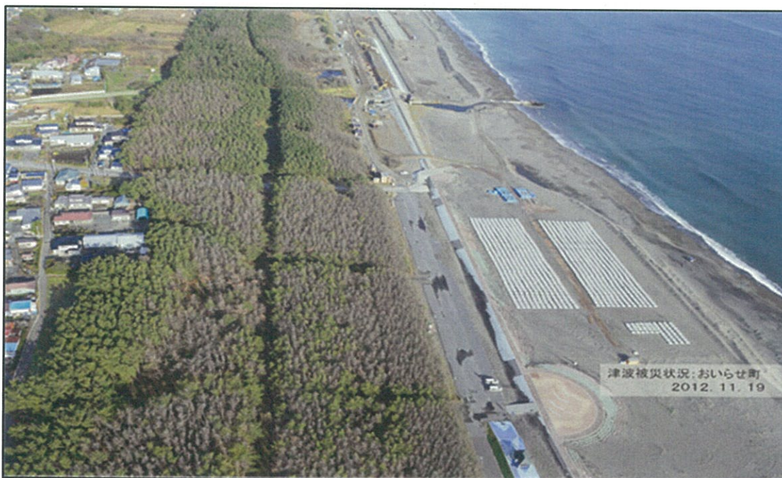
《枯死したクロマツの状況（おいらせ町深沢地区）》
