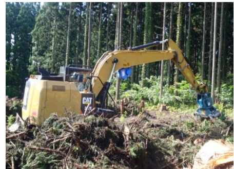
② B工区機械地拵作業状況
