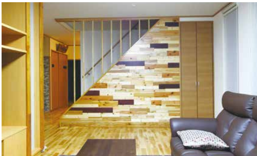
現場から出た木材の端材を張り合わせた“木タイル”。1枚1枚大きさも色も厚みも違う味わいがある(左は拡大写真)
