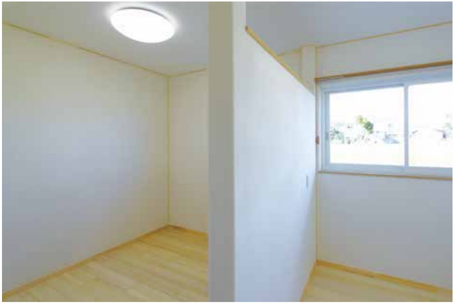
寝室の壁には調湿性や脱臭性、耐火性に優れた珪藻土が使用されている
