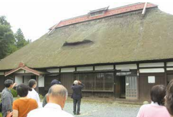
茅葺屋根の勾配の途中に煙出しが付いているところが南部地方の茅葺の特徴の江渡家住宅
