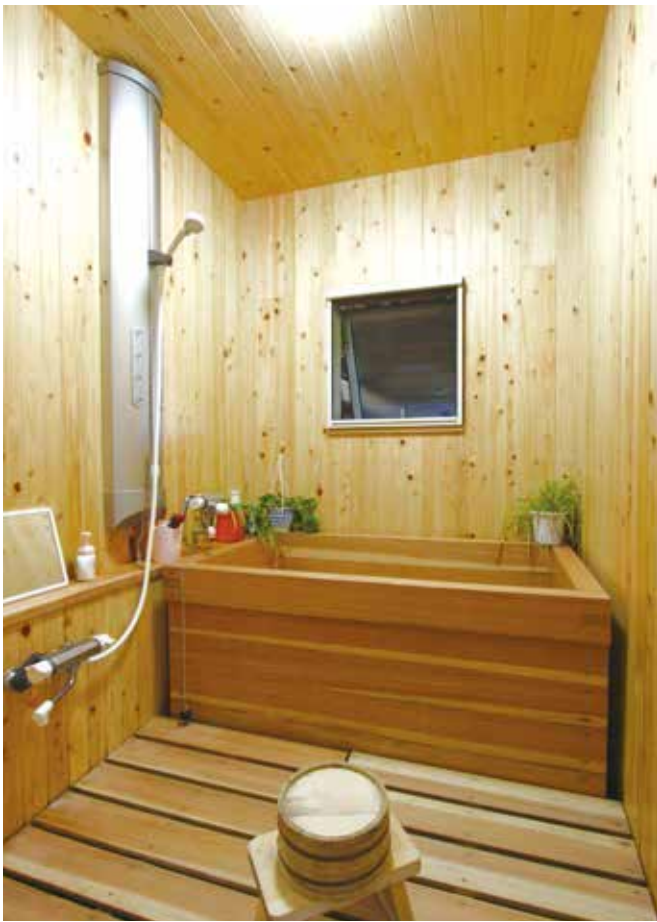
ヒノキ張りの浴室。浴槽はスギ製
