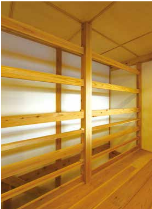
壁の中の「通し貫」 ぬき を、見えるように階段の手摺りに取り入れた
