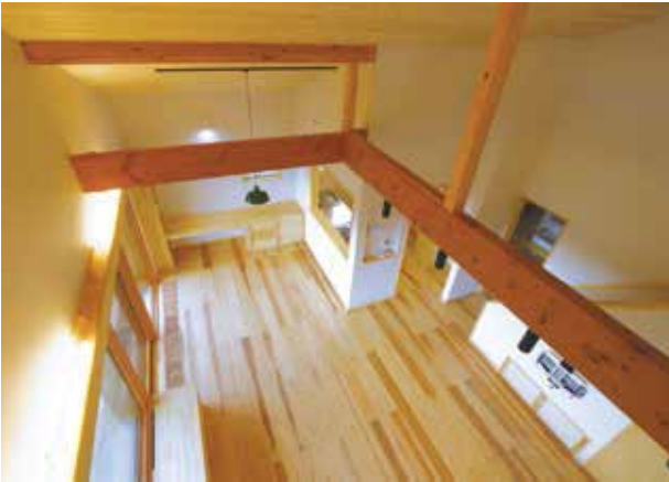
現わしの梁が交差する吹き抜け部分
