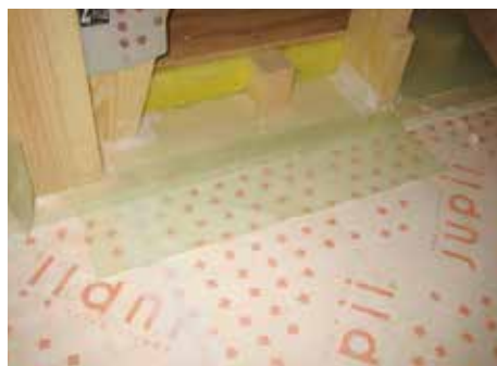
床下もしっかり断熱することで暖房効率もアップ
