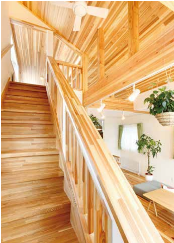
リビングからロフトに上がるタモ集成材の階段。まるで3階建てのよう
