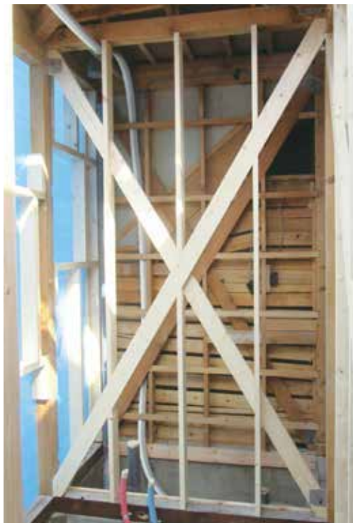
壁には筋違をダブルに入れて耐震性を強化
