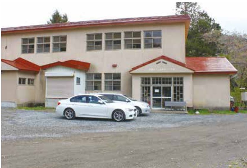
改装中の旧大鰐第三小学校(上)と、「生ハム工房」として生まれ変わった校舎(下)
