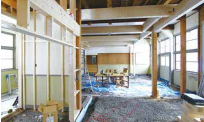
1階の職員室(下)は生ハムの「加工場」と「冷蔵庫」(上)に生まれ変わった
