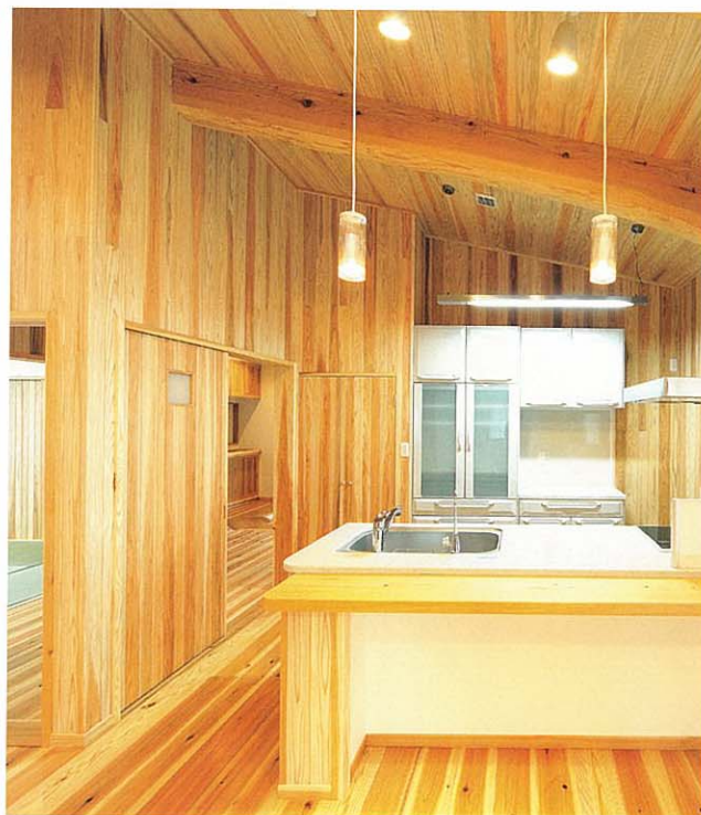
1尺のスギ太材を用いたのほり梁
