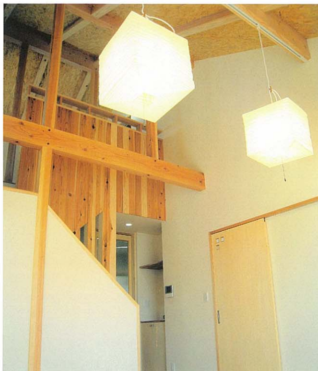
階段吹き抜けにはスギ板を使用
