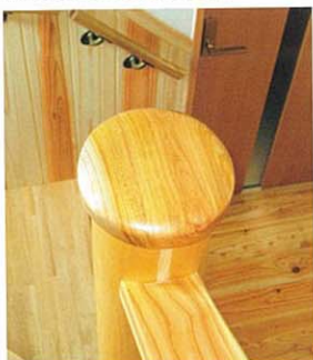
大工の技術により、帽子をかぶせた階段の親丸柱
