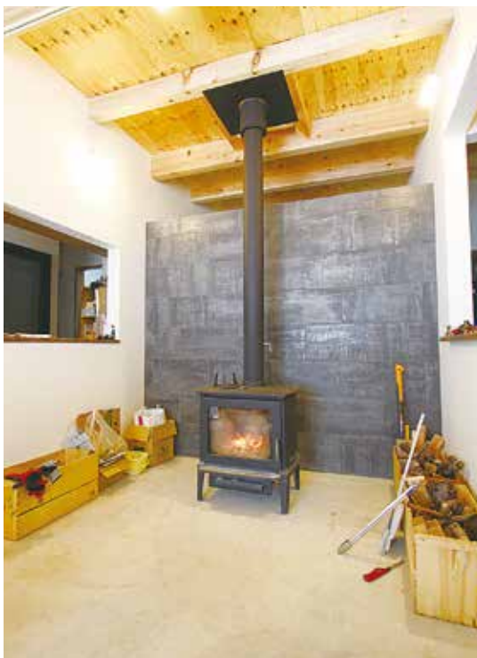
屋内の暖房を一手に担う薪ストーブ。薪はリンゴの剪定枝
