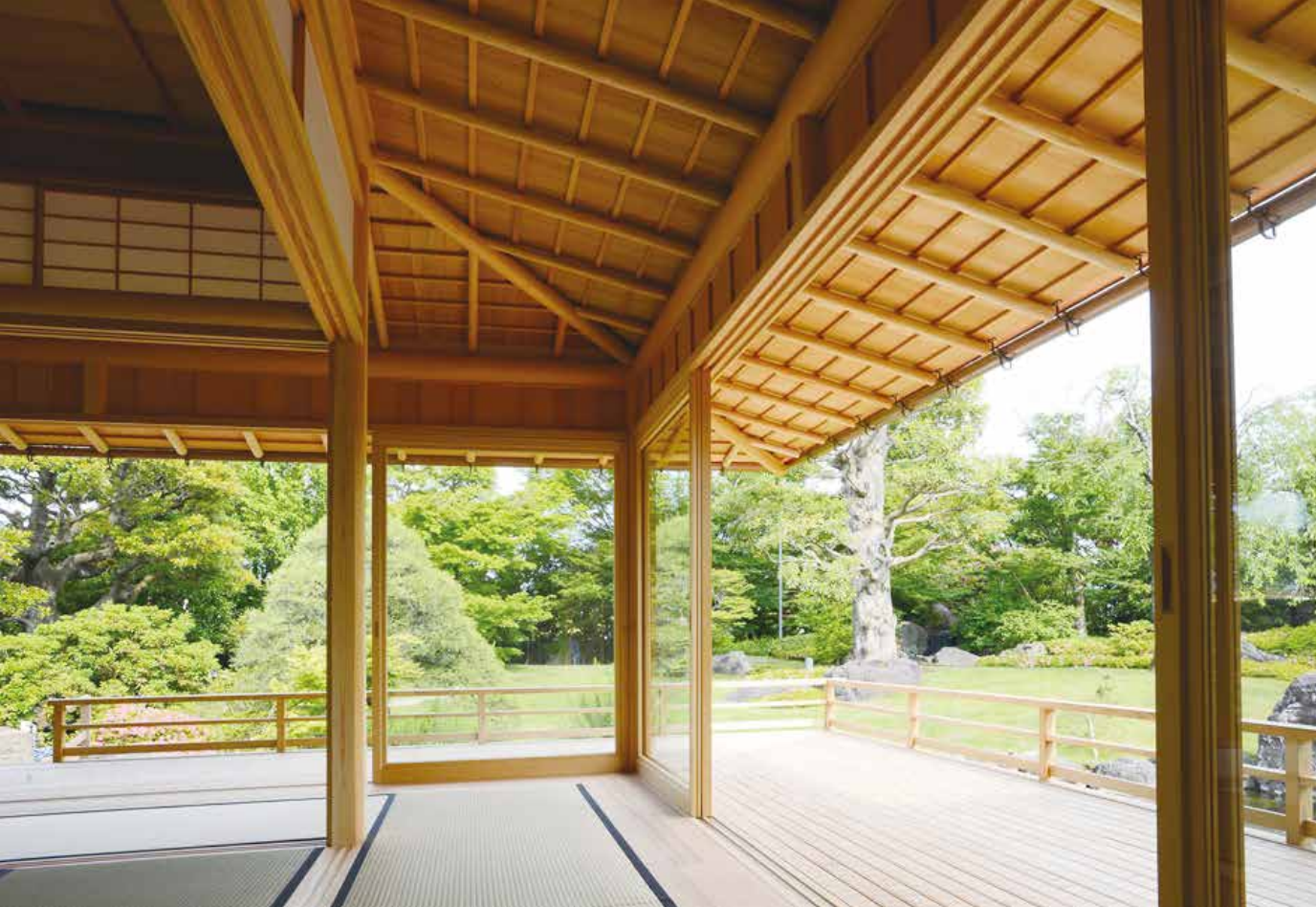
柱の数を抑え、大きな開口から庭を望む美観を支えているのは「桔木」。伝統工法の一つで、桔木を差し入れて下屋を撥ね上げ、柱への荷重を軽減させている（松戸市・W様邸）
