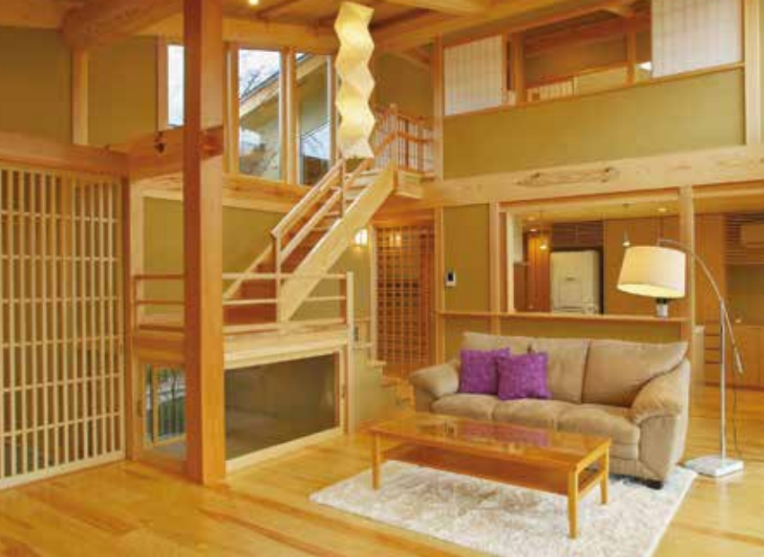
大山の家づくりは山で木を調達することから始まる。梁に見合った赤松を、柱の杉を選び、伐り出し、乾燥させ、加工し、大工が建てる。地元の山と現場を結び付ける、現在では稀な家づくりを展開している
