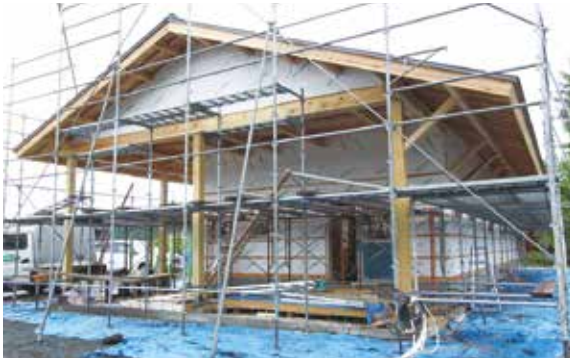
七戸町の平屋の新築現場。玄関の右側に出幅が1間半余りの「下屋」と、L字型に続いて建物の裏にも1間の「下屋」が設けられている
