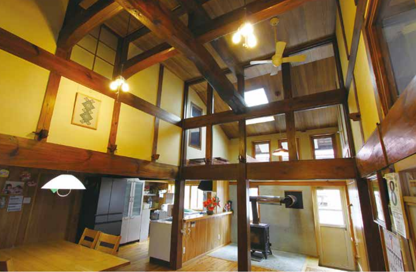
④先代が建てた家を古民家風にリフォームした岩木社長の自宅。天井裏に隠れていたアカマツの太鼓梁を現わしにした室内には築63年の風格が漂っている⑤差鴨居の上部に並ぶ「鼻栓」は、部材を繋ぎ止める伝統の大工の技
