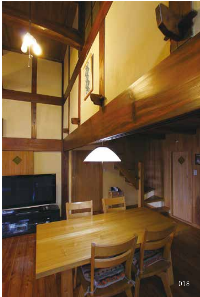
④先代が建てた家を古民家風にリフォームした岩木社長の自宅。天井裏に隠れていたアカマツの太鼓梁を現わしにした室内には築63年の風格が漂っている⑤差鴨居の上部に並ぶ「鼻栓」は、部材を繋ぎ止める伝統の大工の技
