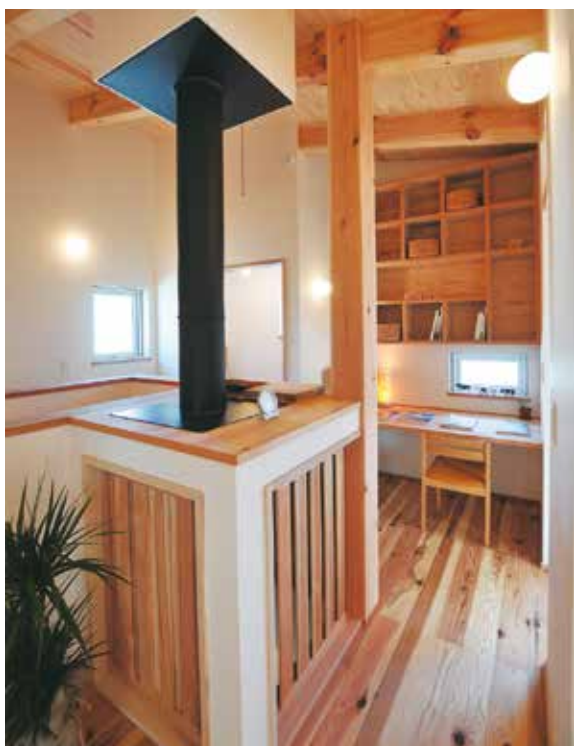
熱を取り出せるようスライド式にした、煙突を囲っている腰壁の木製建具
