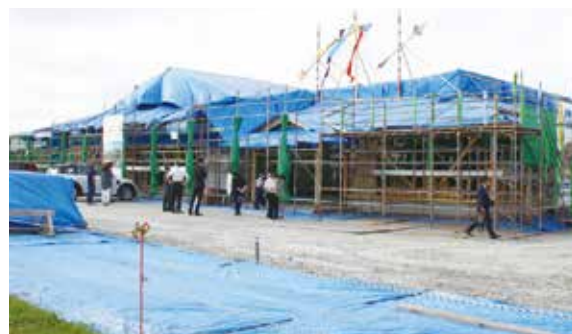
建て方が始まったのが2022年4月。構造見学会が行われたのが9月。5ヶ月経ってもまだ屋根がかからないほどに規模が大きく造りが細かなのだ
