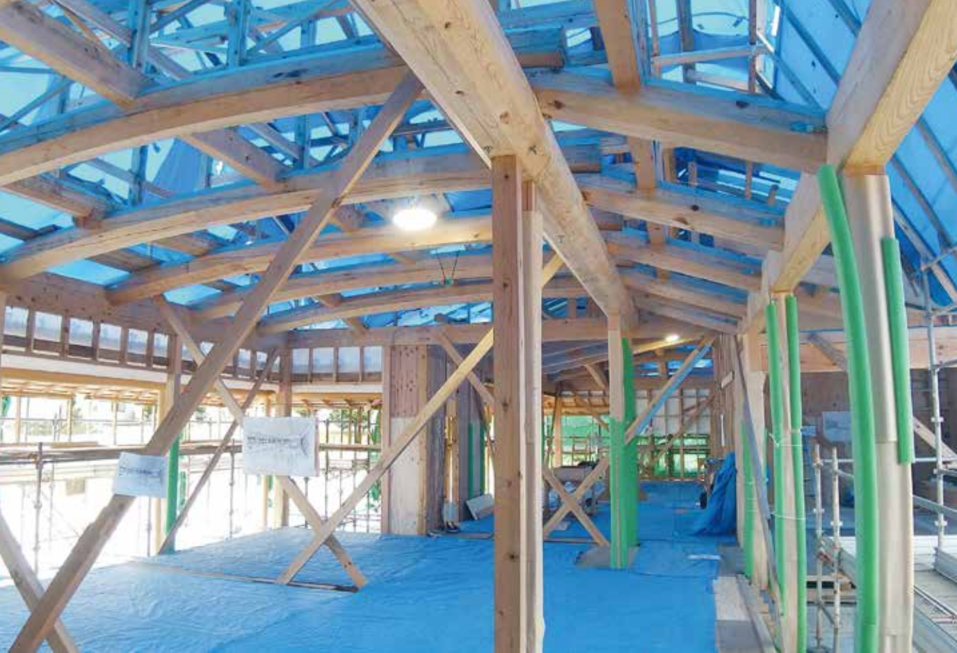
赤松を丸太梁として生かし、八角に落として組んだダイナミックな木の空間
