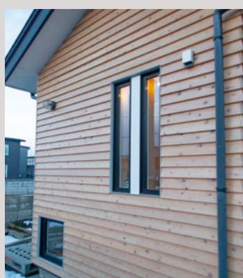
〈外装〉 県産材を使用した部分 スギ(外壁・外側ルーバー)・ヒバ(踏み台)
