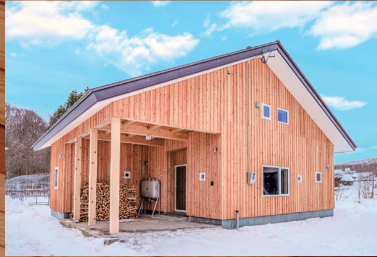
日本の伝統的な技法である大和張りで、木の美しさを引き立てる外観。
