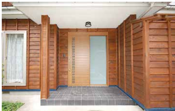
空目のきれいなスギの板を錯張りした玄関回りがいかに古民家風
