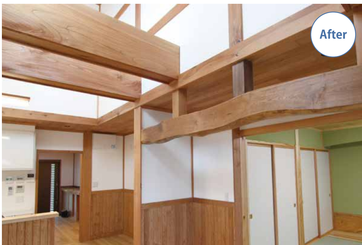
改築前の梁にケヤキを張り合わせた居間の梁(上は工事の様子)
