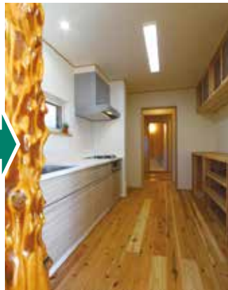
〈改修後〉キッチンと家事コーナーの仕切りに化粧としてイチイを生かした
