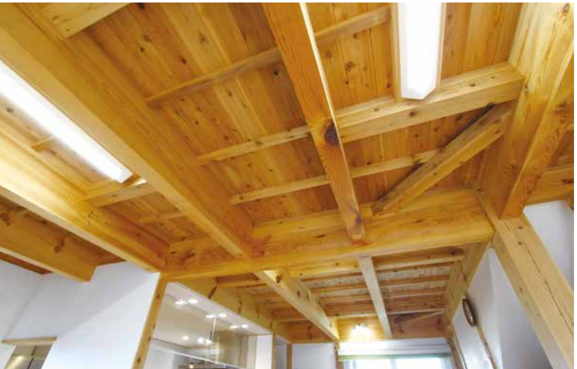
現わしの天井に架けられた頑丈そうなアカマツの梁
