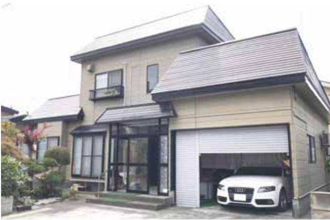
▲リフォーム以前の外観。▼リフォーム後は、風除室の屋根上に雪が盛り上がる問題点がスッキリ解消
