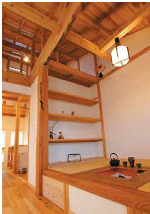
床はスギ、壁は珪藻土、囲炉裏横の柱はイチイ、柱はイタヤカエデ。
