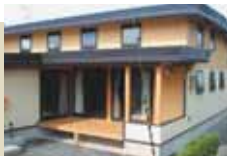
土台は耐久性のあるヒバ、外壁はスギと火山灰シラスの左官仕上げ。
