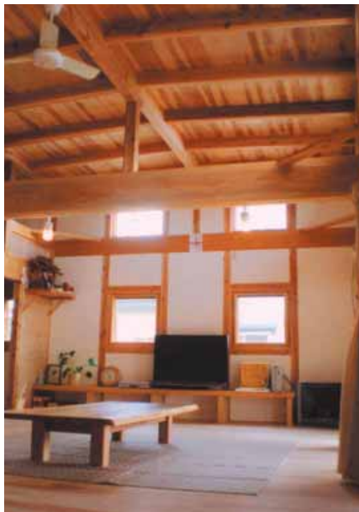
柱、梁、大垂木、床板、天井にスギを使用。
