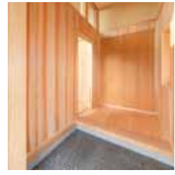
玄関の壁にスギ板を使用。
