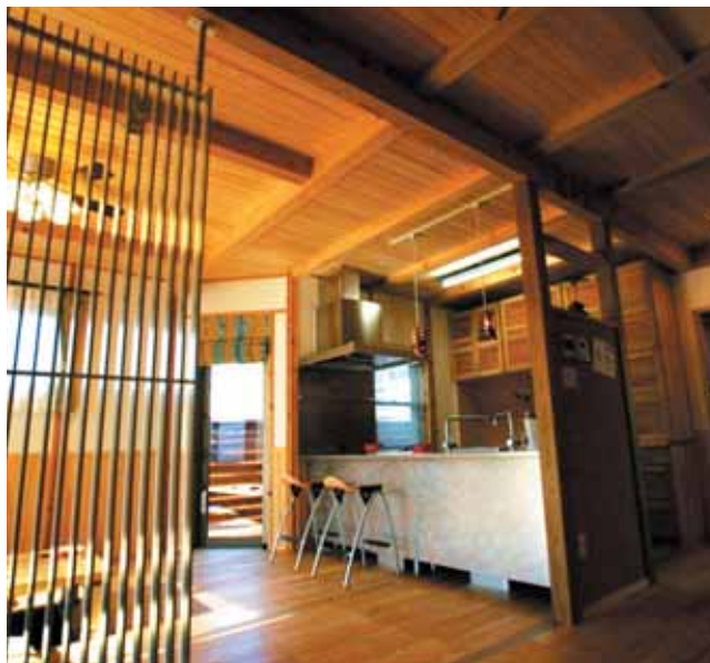
床はクリ、セン、ホオなど、腰壁はアカマツ、天井はヒバ、壁は珪藻土。
