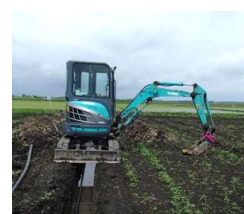
暗きよの補修作業
