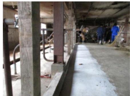
改修された飼槽
