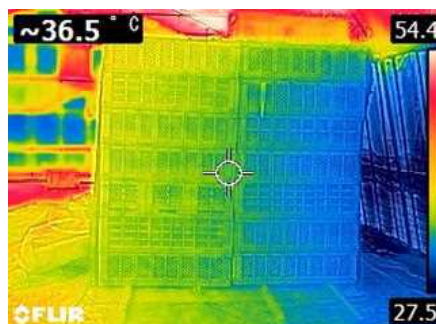
赤外線サーモグラフィで観測した乾燥施設の温度ムラ
