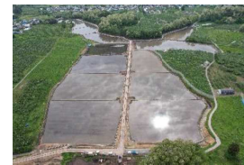
基盤整備後の水田（猿沢地区）
