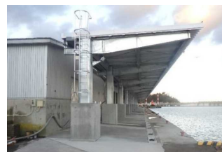
岸壁の屋根（小泊漁港）
