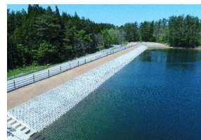
改修を終えた防災重点農業用ため池 （太郎須田ため池）
