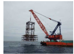
魚礁漁場の整備（魚礁沈設状況）
