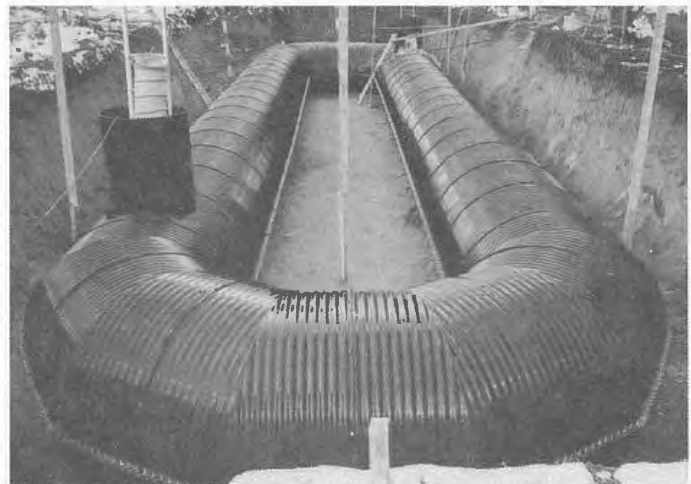
図3 埋設前の酸化溝型曝気槽 (平成15年 青森農林総研畜試)
