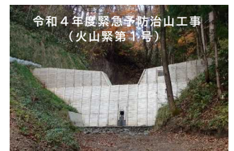
計画的な治山施設の整備
